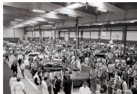
Frå opninga av "Motorland" laurdag 6. september 1986 i bygget som 10 år seinare vart opna som Bjerkreimshallen. Svein Landsnes hadde samla 100 bilar i hallen og det kom tjukt av folk for å kjøpa bil, og å få med seg show med blant anna Torkel Ravndal og John Klemetsen. To år seinare kjøpte banken hallen på tvangsauksjon. Bilete har Bjørn Hille teke.
