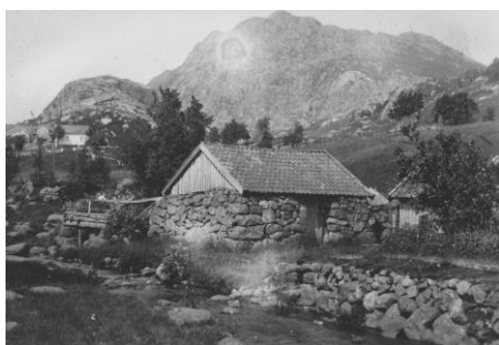
Tørkehuset med vasshjulet på venstre side som drog treskemaskinen på lensmannsgarden. Snora gikk i bein linje forbi lensmannshuset og inn på låven. Under treskinga stengte de vege for omkjøring forbi Petter-garden.
