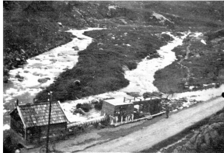
Kraftverket med den første inntaksdammen hadde liten fallhøyde.
