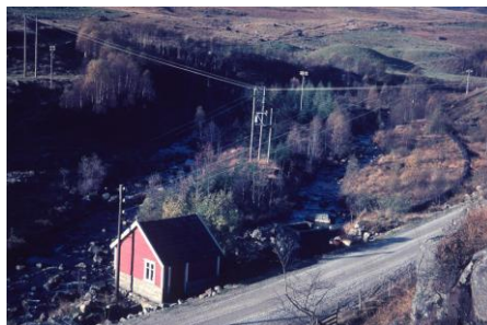
Kraftverket ved Skjævelandsåna. Foto: Per Espedal.
